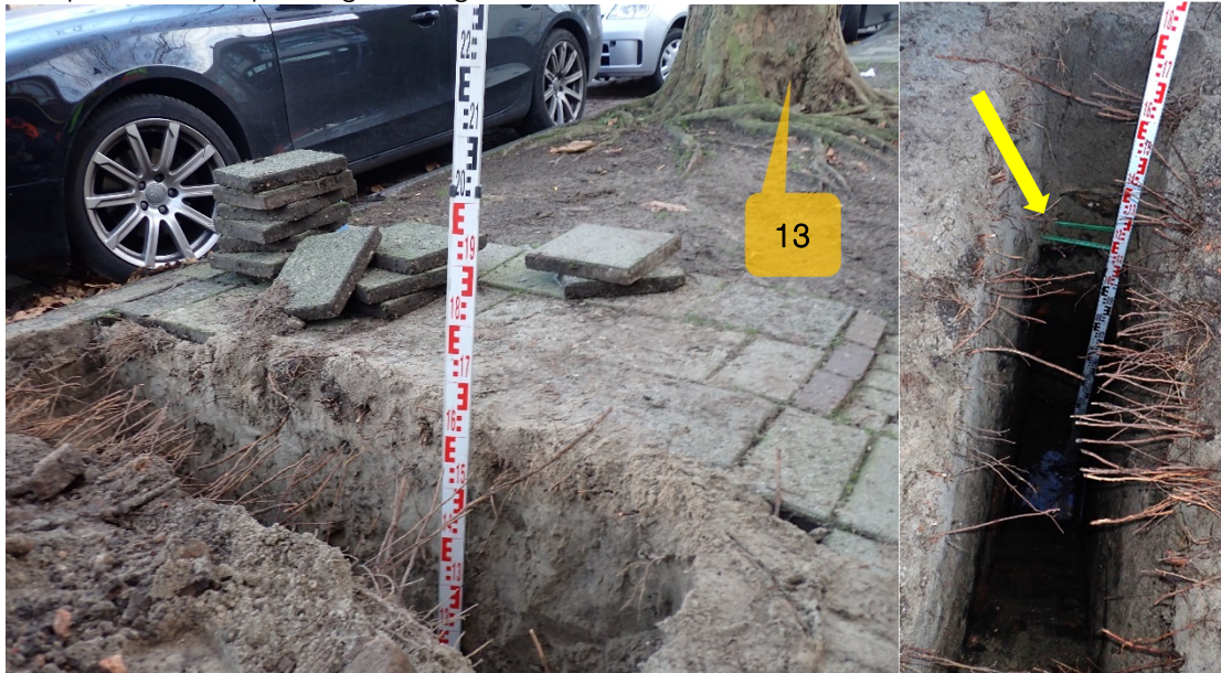
Foto 7: Links: profielsleuf 3 (P3) bij boomnummer 13, 3,2 m uit de stamvoet aan de westzijde. Rechts detailfoto van P3, de gele pijl geeft de aangetroffen kabels weer.
